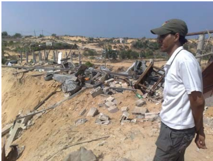
Le résultat d'une frappe aérienne sur la maison de 'Atwa Abu Sitta à Khan Yunis le 16 Septembre 2010
