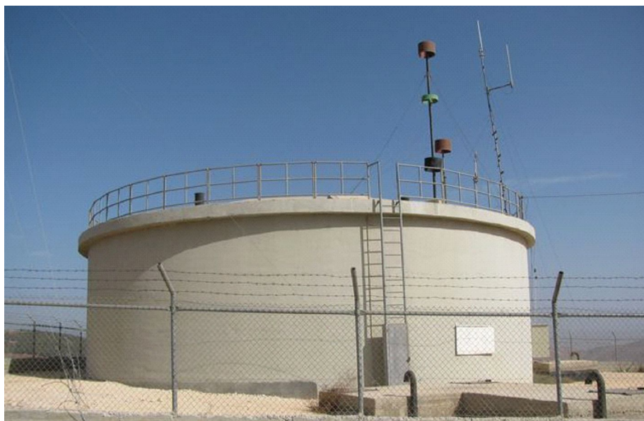
A Tubbas, un château d'eau construit avec la participation des communes de St-Pierre d'Aurillac et Fargues de Langon
